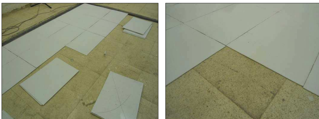
Imágenes 3 y 4 Detalles de la instalación de la muestra en la sala reverberante
